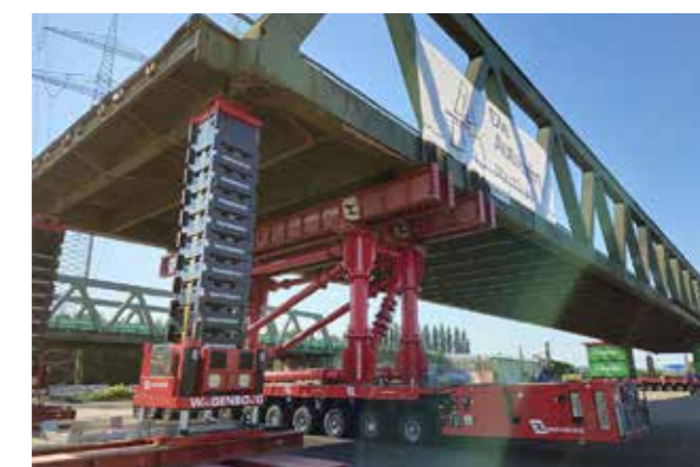
Oktober: Verplaatsing 125 meter lange Duitse brug
