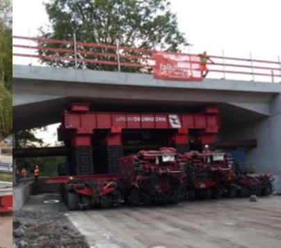
Eisenbahn Überquerung Rauchstrasse - Essen, DE Item details: Rail bridge of 1.400 ton Equipment: 48 axle lines SPMT
